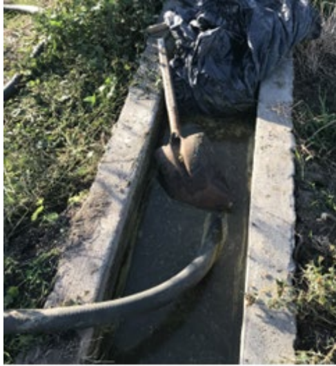
Figura 10. Efluente crudo represado y bomba de extracción.
