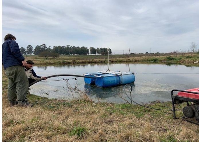
Figura 12. Extracción de efluente de laguna.
