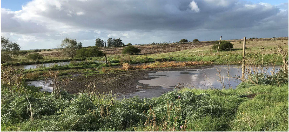
Figura 9. Sistema de lagunas de tratamiento: anaeróbica y facultativa.
